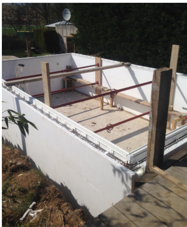
Versteifung der Poolwände vor der Befüllung
