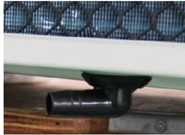
Unter der unteren Verkleidung
